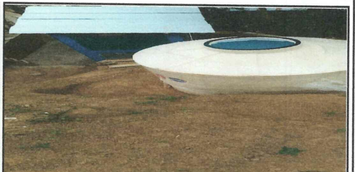
Foto 6: TINACO COLOCADA DE 2500 LITROS
