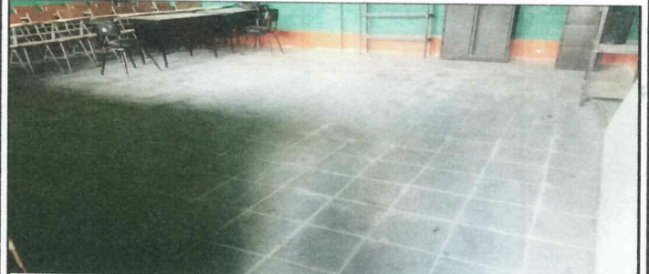
Foto 4: COLOCACIÓN DE PISO CERAMICO ANTIDESLIZANTE PARA TENER UN MAYOR CONFORT EN LA ESCUELA.
