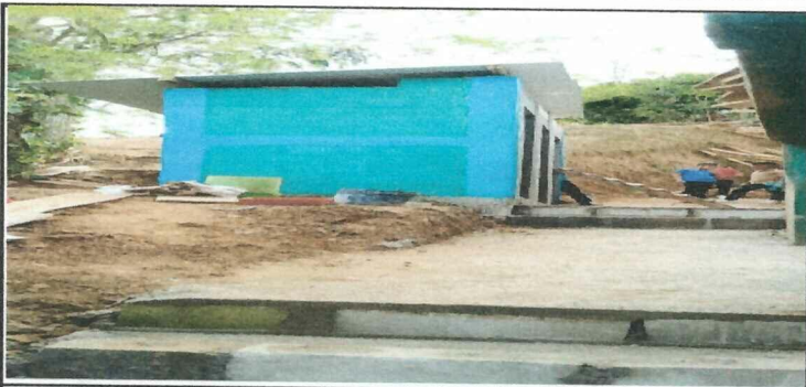
Foto 5: BAÑO REHABILITADO TRES BATERIAS
